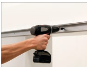
1. Mocowanie szyny jezdnej od frontu
