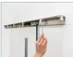
4. Montaż uchwyty maskownicy tym samym kluczem imbusowym
