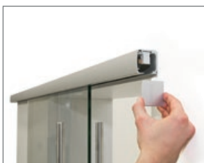
6. Nakładanie zaślepek bocznych
